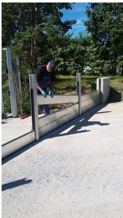
En prøveopsætning har vist, at barrieren kan være "kampklar" på et kvarter.
