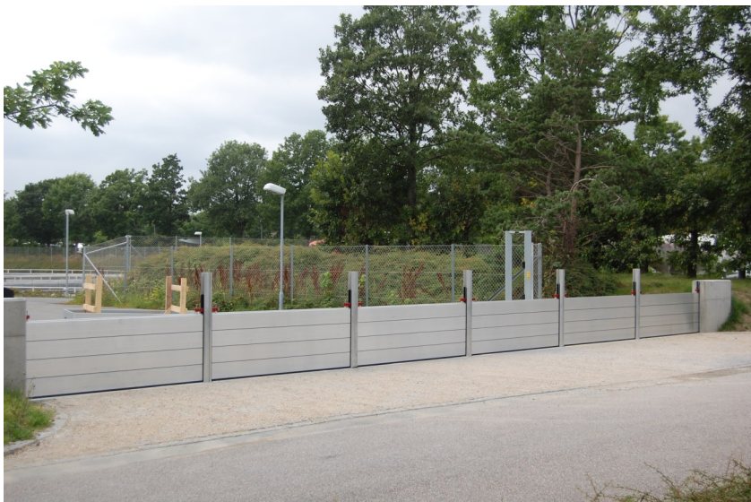
Denne PREFA® Vandbarriere er opdelt i seks felter. Da alle dele er udført i aluminium, kan hele barrieren betjenes af én mand.
