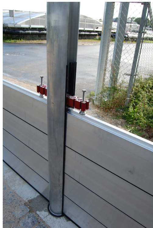
Bjælkerne holdes fastspændt mod underlaget med special- skruetvinger.
